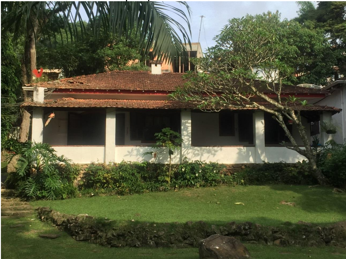
Foto 1: Fachada frontal da casa principal
